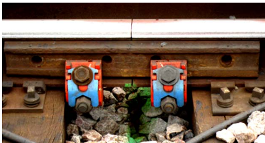
Figur 10.4 Korrekt montering af en midlertidig laskning med skruetvinger symmetrisk om åbningen. Befæstelserne på underlagspladerne er midlertidigt afmonterede, men skal rettelig være monterede før idriftsættelse.
