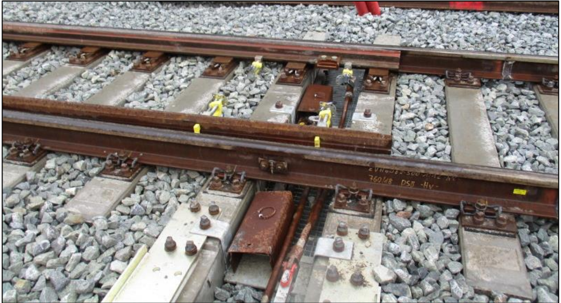
Billedet viser placering af de to låsebolte på til- og fraliggende tunger ved 1s drevs position
