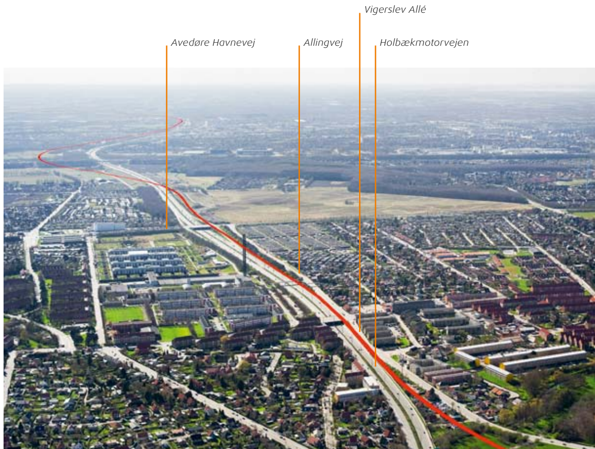
Fra Vigerslevparken anlægges den nye bane på nordsiden af Holbækmotorvejen frem til Brøndbyøstervej.
