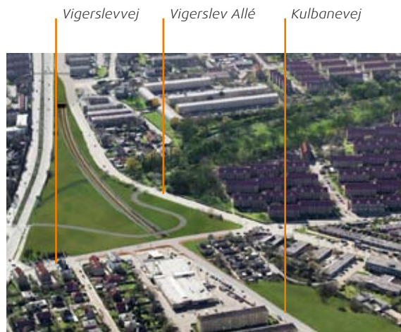
Bane i tunnel ved Kulbanevej og med åben afgravning gennem Vigerslevparken.
