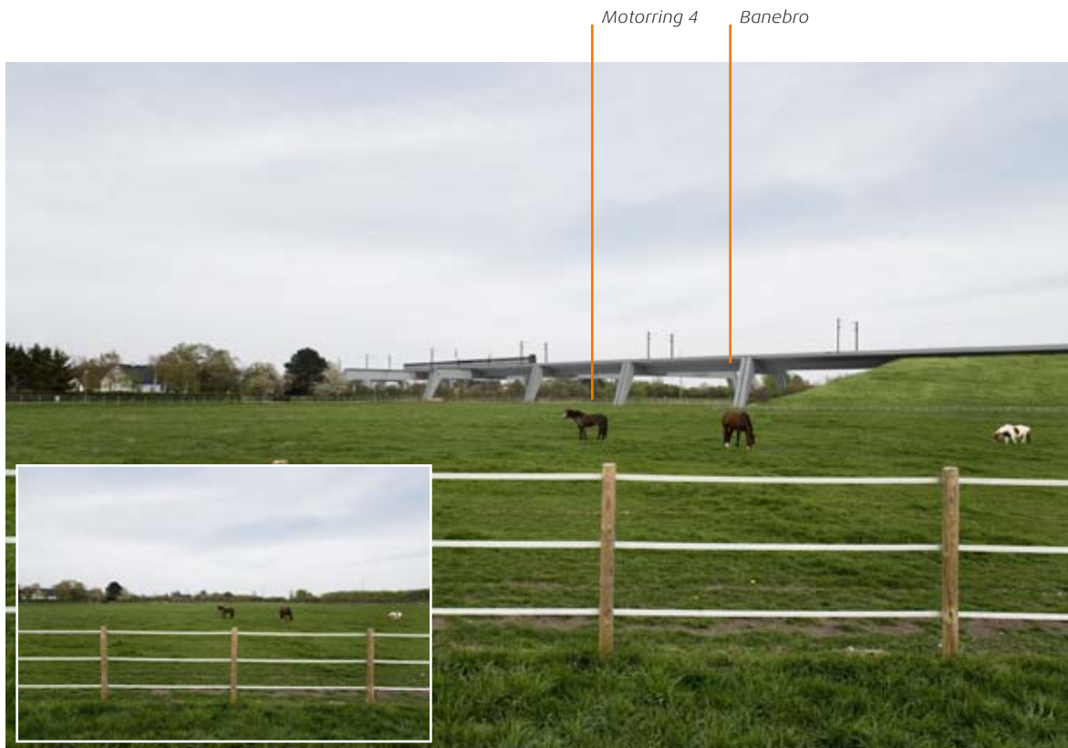
Efter Vallensbæk Sø føres banen fra dæmning over på en bro, der hæver sig højt over landskabet for at føre banen over Motorring 4 i en spids vinkel. Banebroen ses fra Tranegilde Mark mod nordvest.
