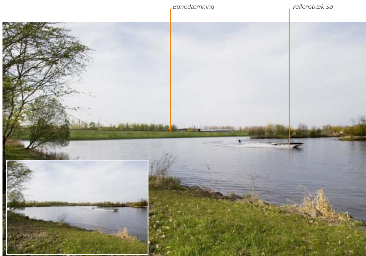
Den nye bane anlægges nord om Vallensbæk Sø på en dæmning. Baneskråningen giver plads til en stiforbindelse langs søen og til tilskuerpladser til vandskiaktiviteterne.
