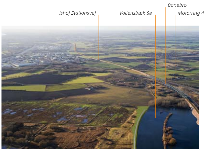
Efter Vallensbæk Sø føres banen fra dæmning over på en bro, der hæver sig højt over landskabet for at føre banen over Motorring 4 i en spids vinkel. Banebroen ses fra Tranegilde Mark mod nordvest.
