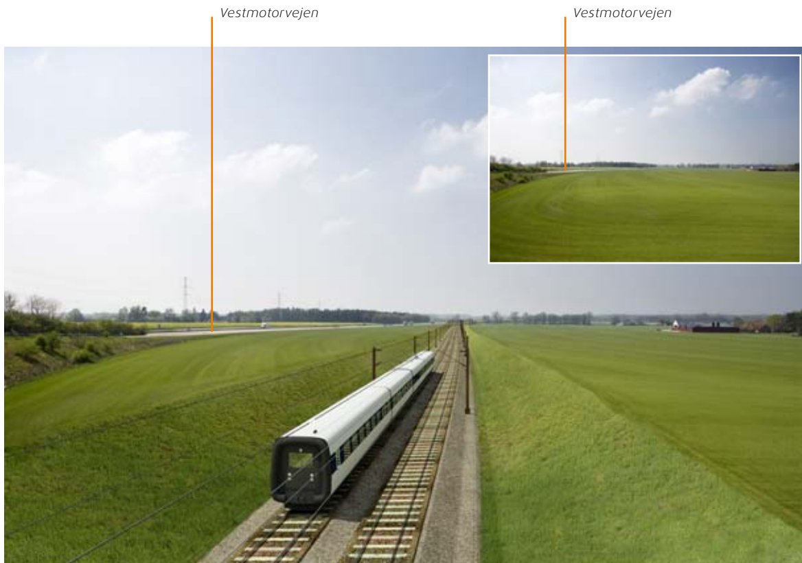
Den nye bane anlægges langs Vestmotorvejen på nordsiden. Ved Vestre Ringvej ligger banen i åben afgravning, således at udsynet over landskabet bevares.
