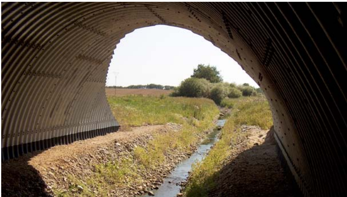
Eksempel på faunapassage med tørre jordbanketter på begge sider for passage af større dyr.
