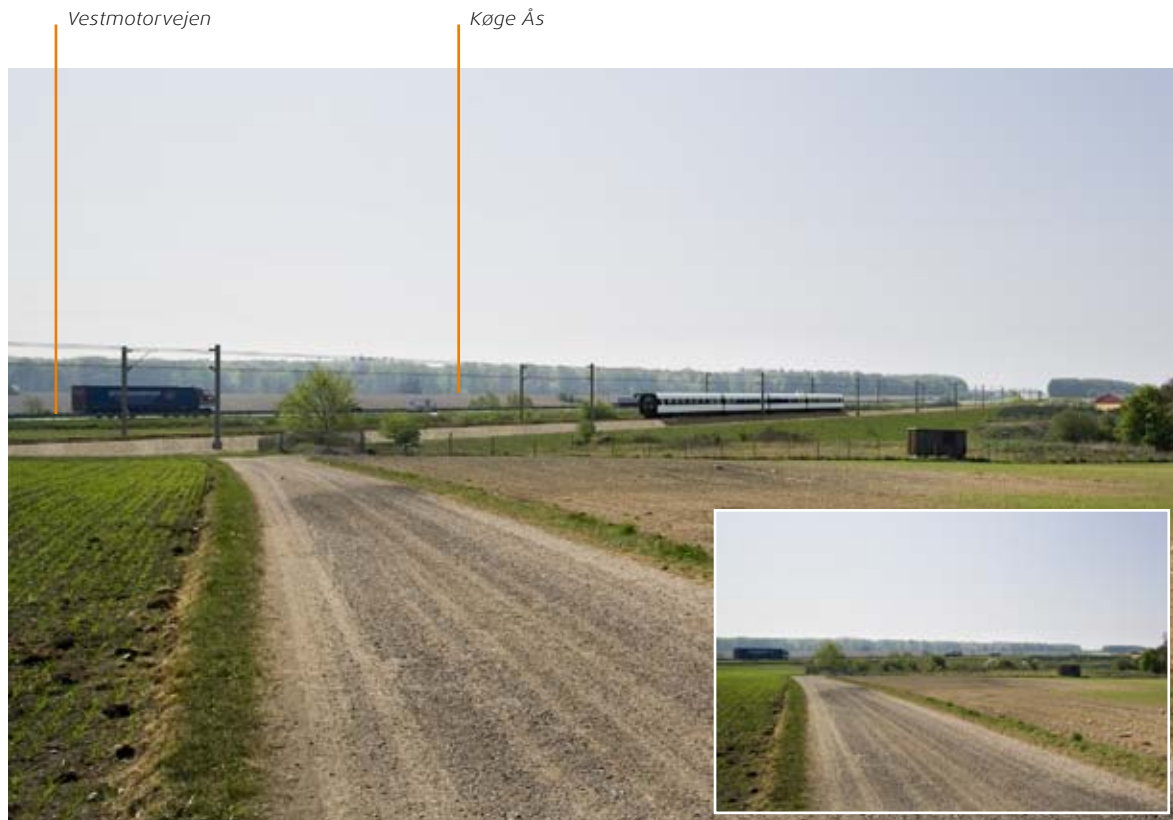
Den nye bane krydser Køge Ås tæt op ad motorvejen.
