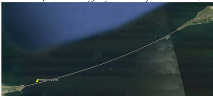
Figur 1 Oversigt over Vestbroen. Sprogø øverst til højre, landfæstet ved Knudshoved nederst til venstre. Kollisionsstedet (km 127,440) er markeret
