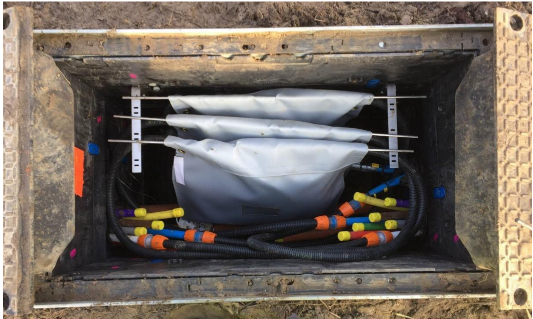
Figur 5 Indføring af rørpakken i brønd
