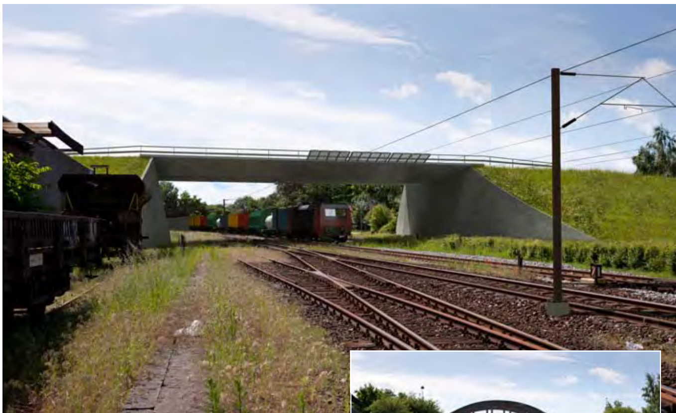
Den nye bro ved Rampen i Næstved. Den nuværende bro, som ses til højre, er for lav til elektrificering og må derfor udskiftes med en ny.
