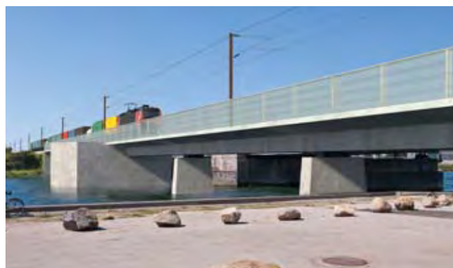
I Grundløsning 1 og 2 etableres ny klapbro over Masnedsund. Her ses den nye bro fra Vordingborg Havn.
