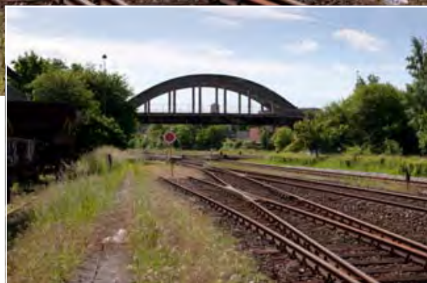
Den nye bro ved Rampen i Næstved. Den nuværende bro, som ses til højre, er for lav til elektrificering og må derfor udskiftes med en ny.
