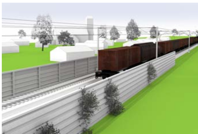
Støjskærme opstilles gennem flere byer – som udgangspunkt i en højde på to meter over skinneoverkant.
