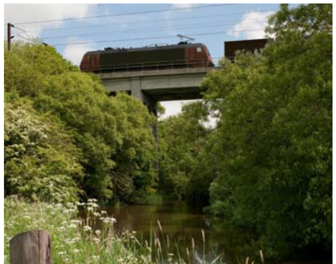
Den elektrificerede bane passerer Suså på en bro.
