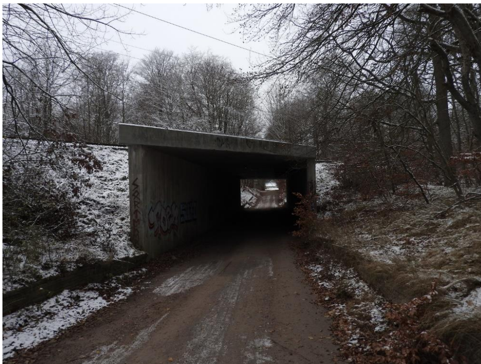
Figur 4-10 Eksisterende vejunderføring ved km 21,55
